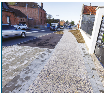
Aménagement de trottoirs, Beaumont-en-Cambrésis
