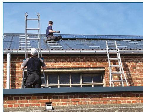
Pose de panneaux photovoltaïques aux services techniques communaux, Deùlémont
