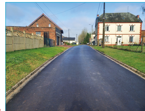
Réfection de la rue du Four, Doignies
